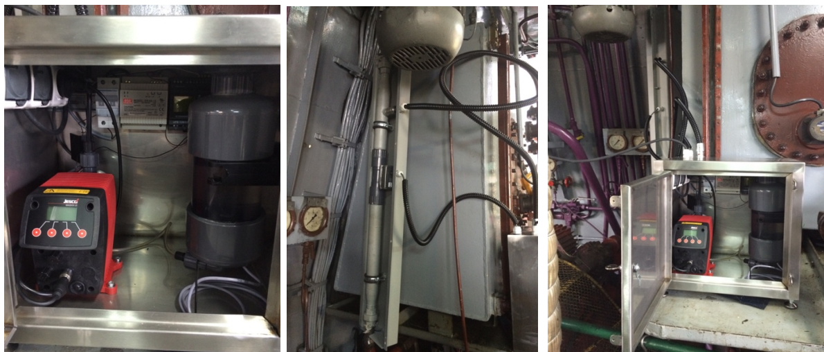
Rys. Elektroniczny system podawania katalizatora do paliwa
